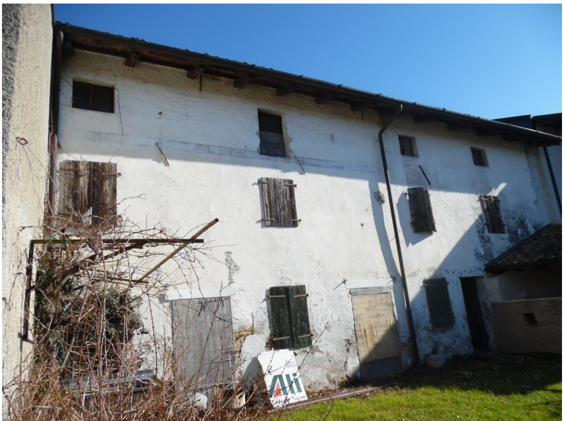
Abitazione (rustico) - Corpo A.1, subb. 1 e 5, mapp. 161
