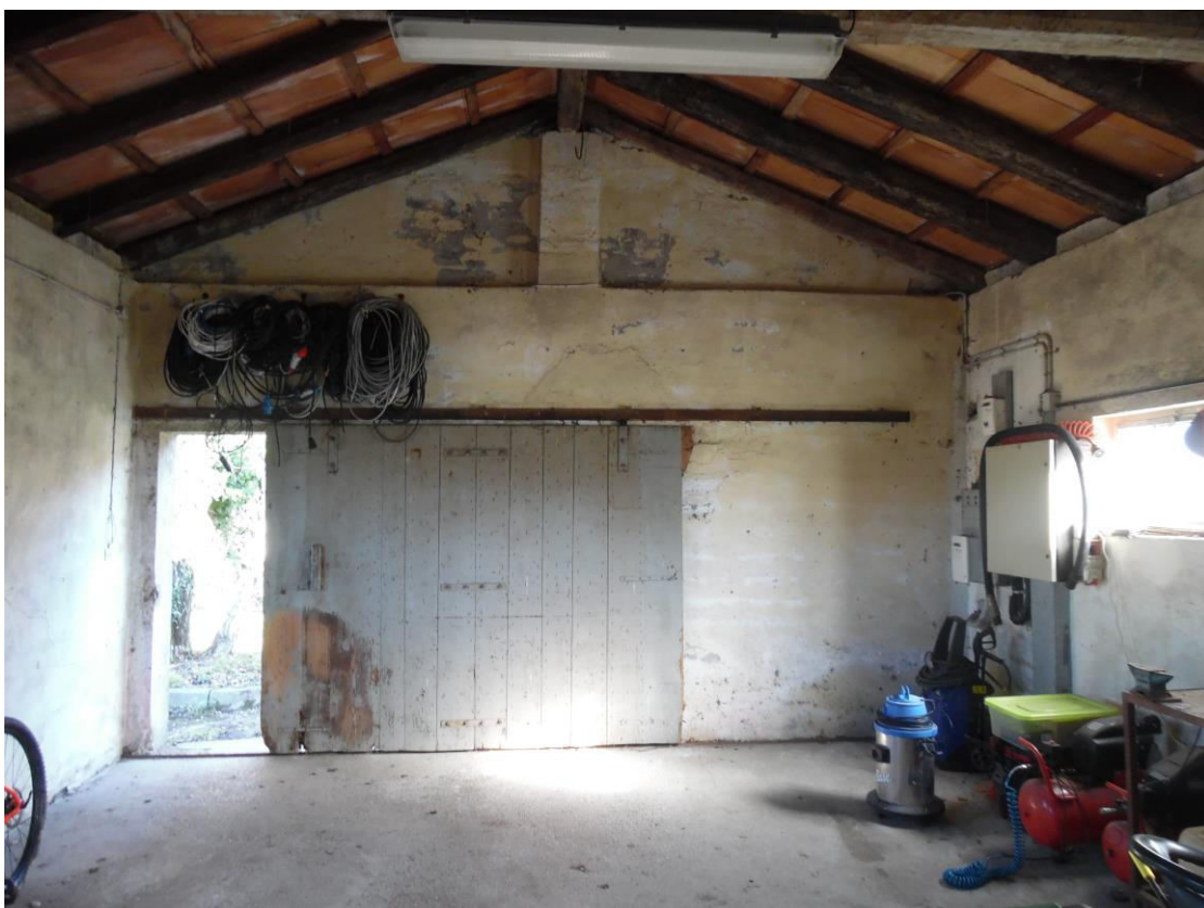
Autorimessa - Corpo A, sub. 4, mapp. 157, p.T
