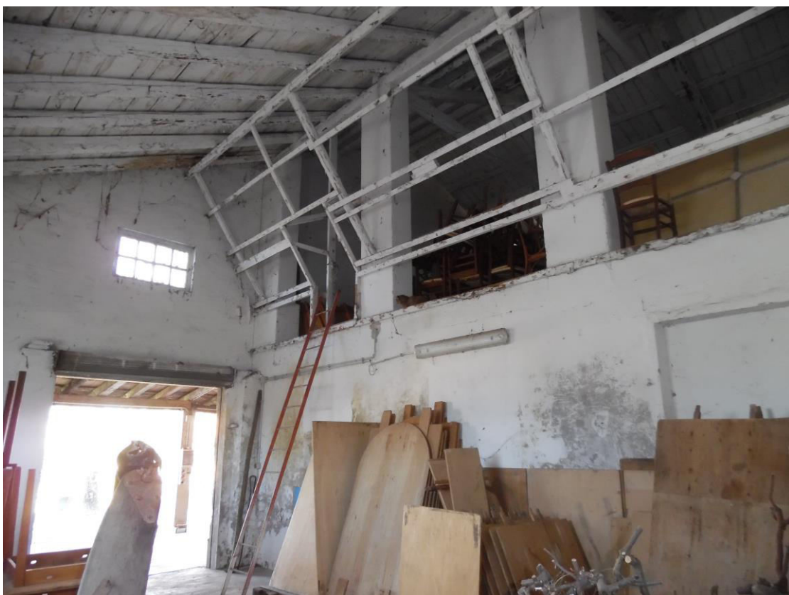
Deposito attrezzi – Fabbricato rustico accessorio - Corpo A, sub. 1, mapp. 157, p.T
