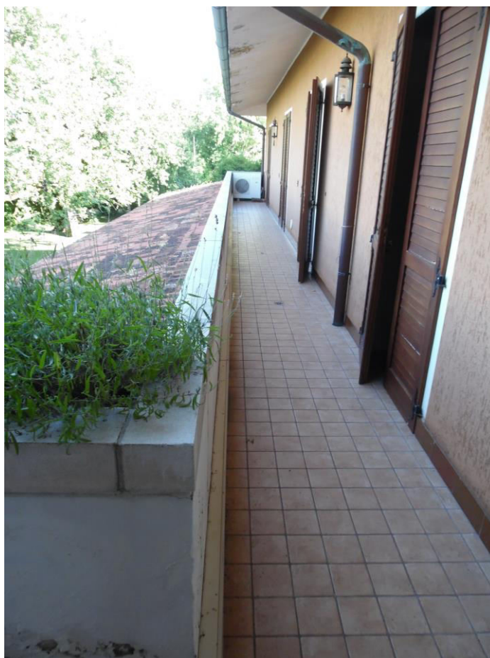
Balcone - Corpo C, sub. 3, mapp. 157, p.1
